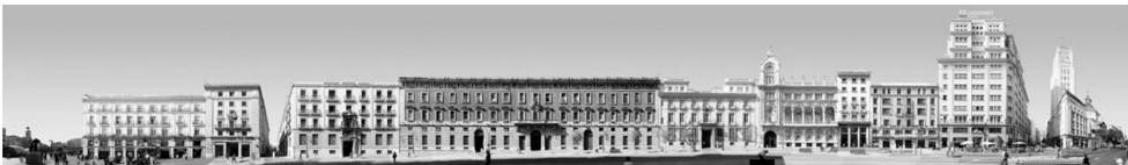
Figura 11. Palacio de la Aduana y edificios contiguos en la calle de Alcalá
